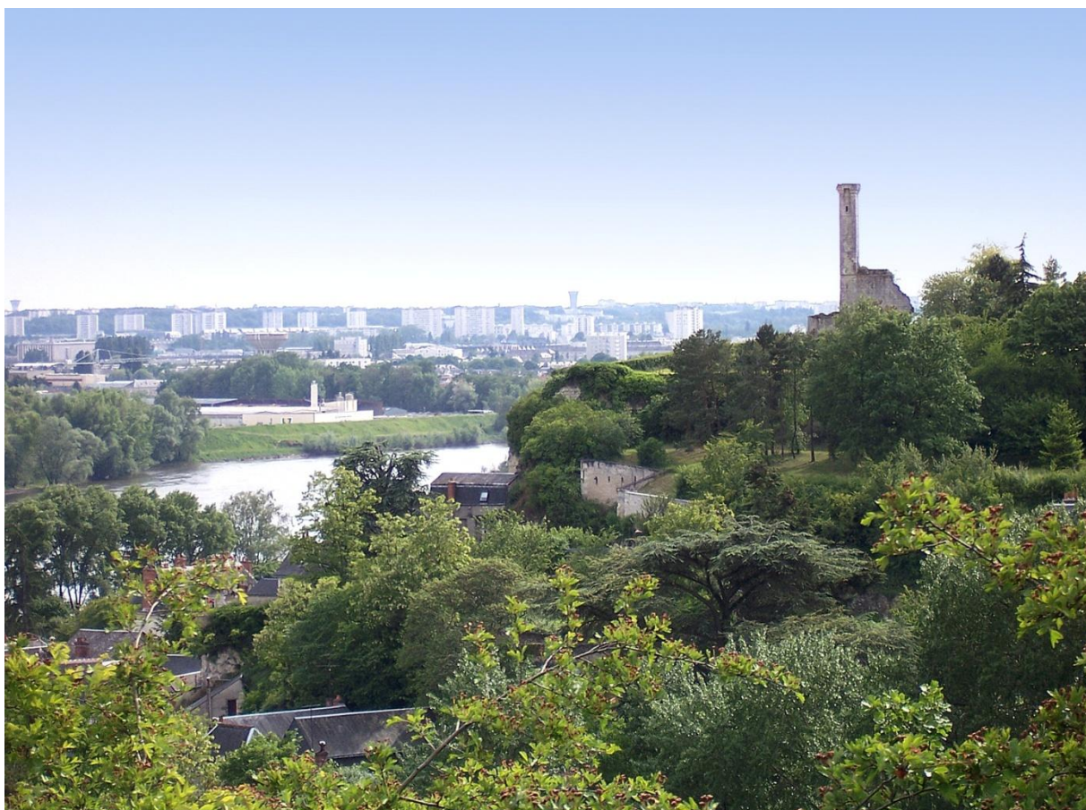
Des travaux de consolidation longs et coûteux pour sauvegarder la lanterne de Rochecorbon
